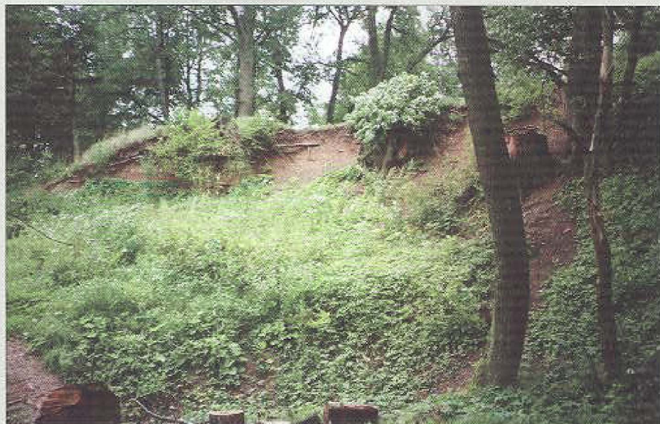
Griūvantis Ažuolpamūšės (Pasvalio r.) piliakalnio šlaitas į Ugę. 2001 m.
